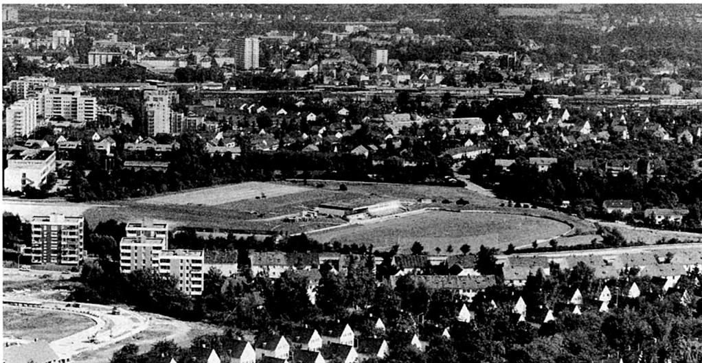
Nach der Fusion begannen die Ausbauarbeiten am Kaulbachweg am 6. August 1986.
