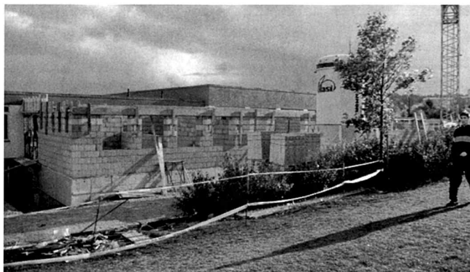
Baubeginn für den West-Anbau ans Vereinsheim.
