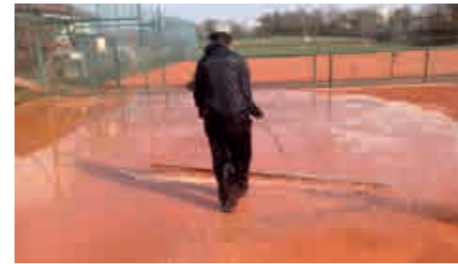
Einschlämmen und Abziehen
