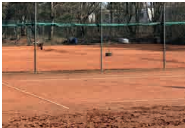
Abtrag des Altmaterials
